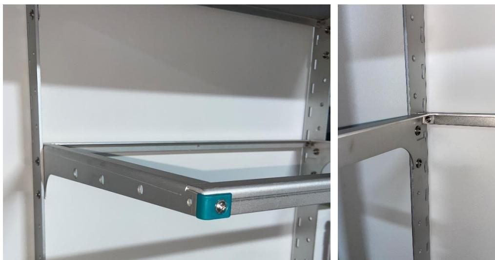
8. **Clipmuttern festziehen und alle anderen Schrauben nochmal auf festen Sitz kontrollieren.** Bei dem Festziehen der Clipmuttern darauf achten, dass diese nicht verkanten, sondern sauber in das Loch eingezogen werden und den Ausleger fest anpressen.
